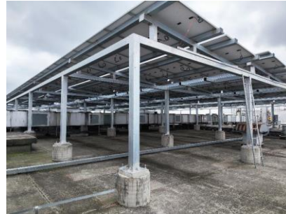
图：钢结构支架
